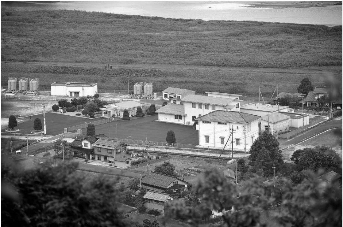
出西水源地全景
