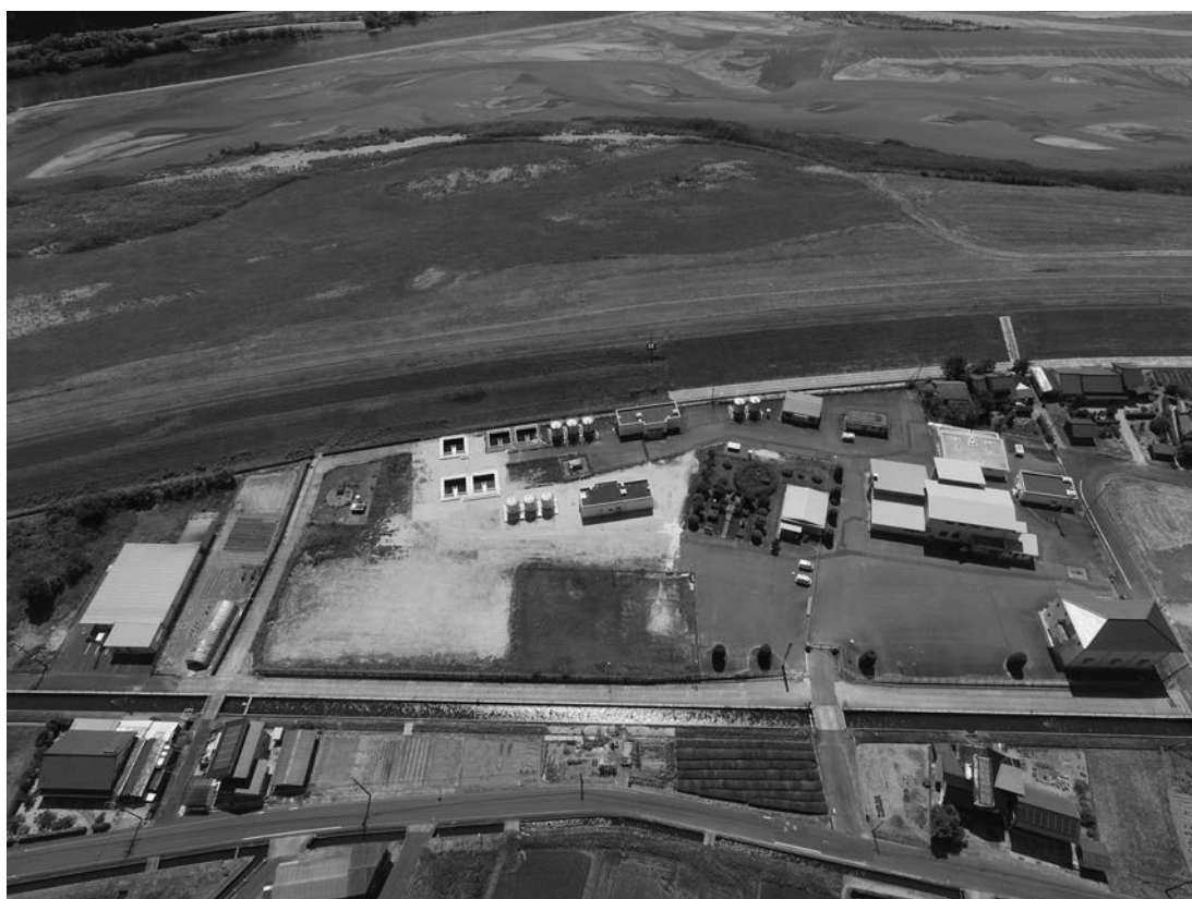
出西水源地（上空から撮影）
