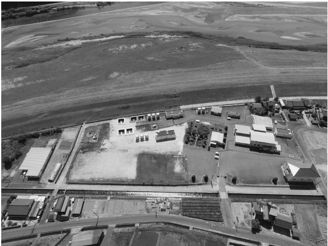
出西水源地（上空から撮影）
