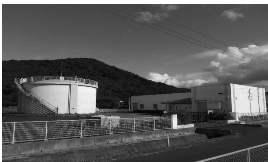
工業用水道水源地
