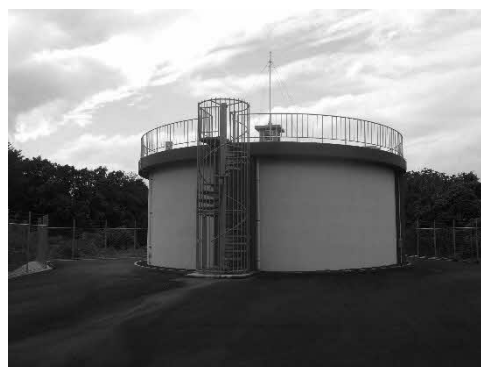
新大野原配水池
