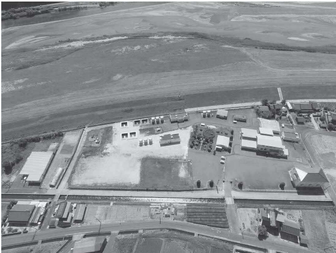
出西水源地（上空から撮影）
