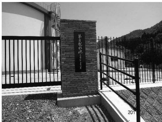
第8 配水池門扉
