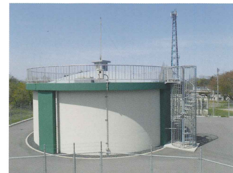
9 新大野原配水池
