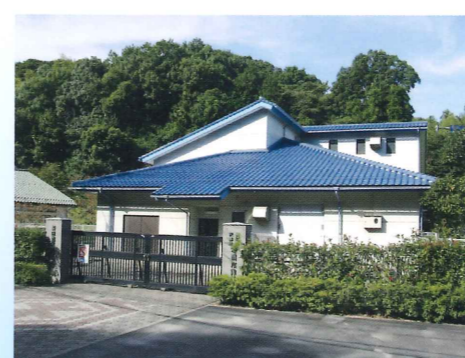
4 荻田ポンプ場
