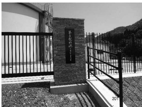
第8 配水池門扉
