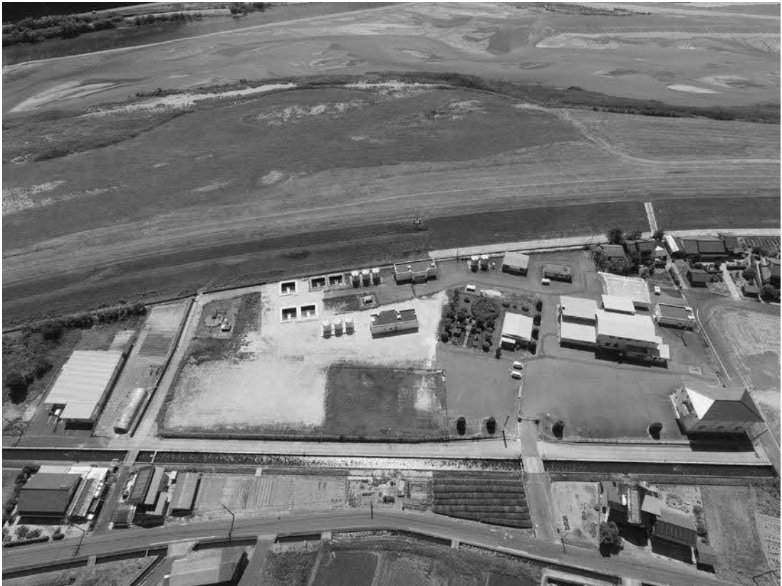
出西水源地（上空から撮影）
