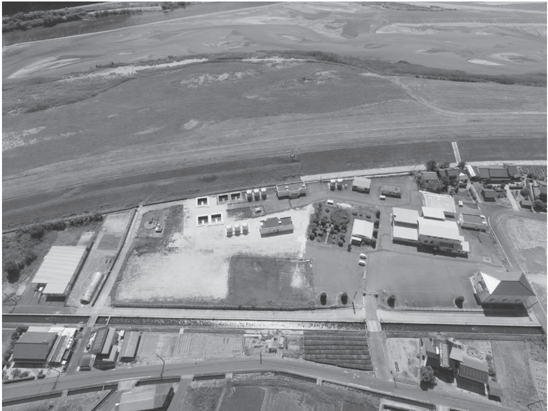
出西水源地（上空から撮影）
