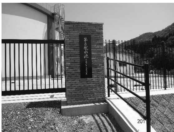
第8配水池門扉
