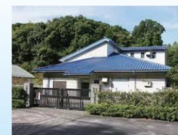
④ 荻田ポンプ場
