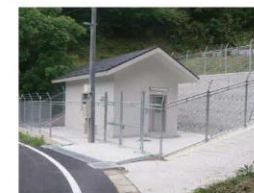
⑦ 金山ポンプ場
