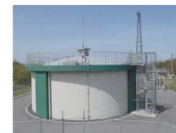
⑨ 新大野原配水池
