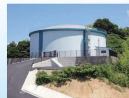
③ 直江配水池
