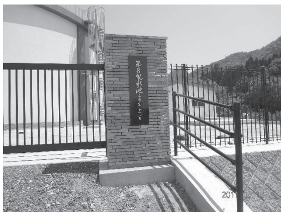
第8配水池門扉
