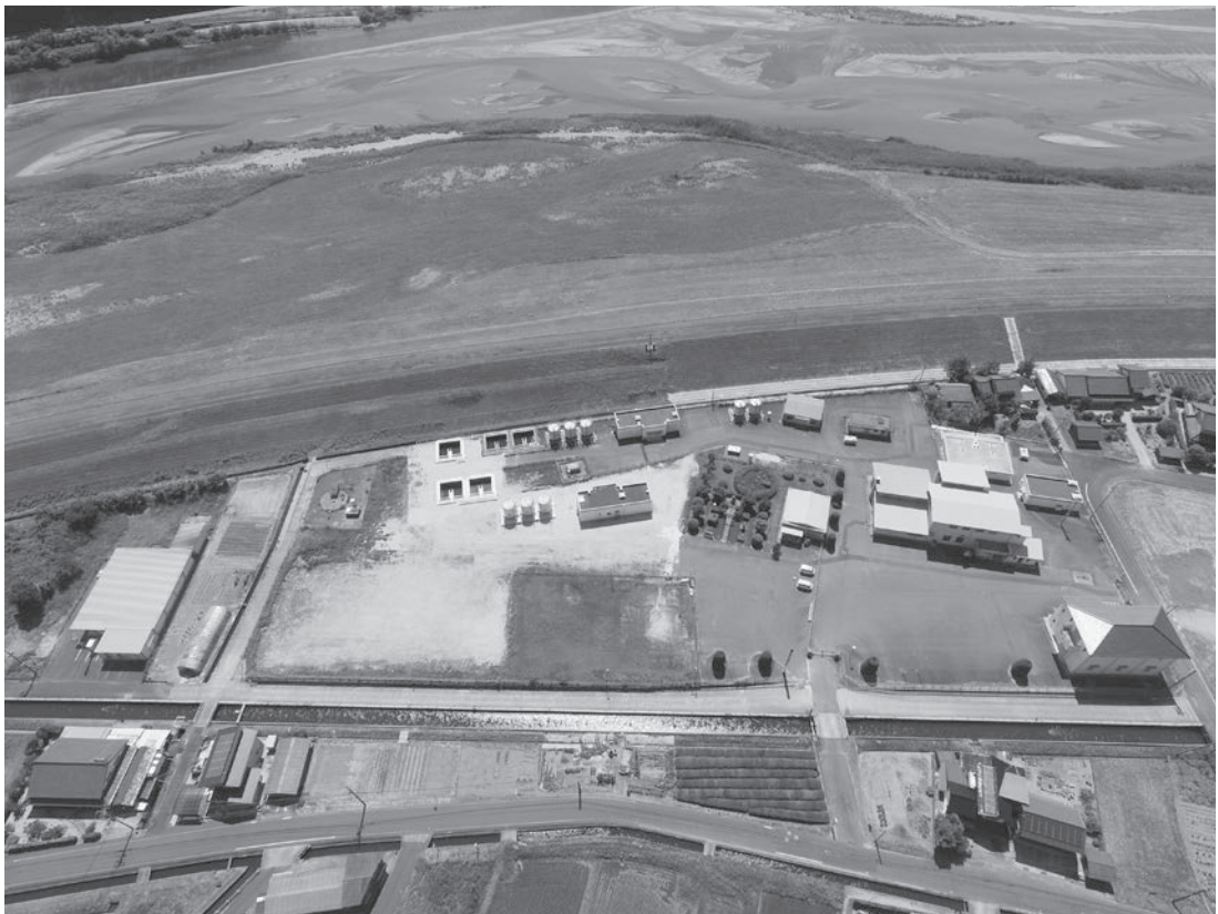
出西水源地（上空から撮影）
